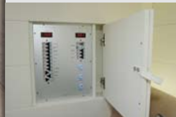
El panel eléctrico se sitúa en el interior y queda perfectamente oculto tras una tapa.
